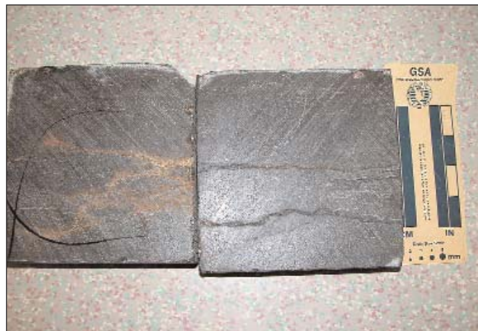
Doorgezaagde boordsteen. Bruine verkleuring van Chinese blauwe steen, langs weerszijden van vochttopnemende zwarte voegen (styloliet) (COPRO-staal)
