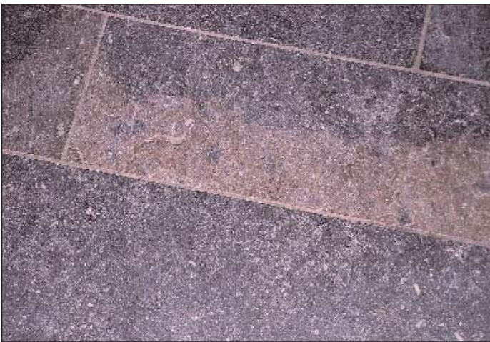
Beige tot bruine verkleuring van gezoete vloertegel (ingang ziekenhuis, Hasselt). Allicht speelt het gebruik van agressieve schoonmaakproducten een rol bij de oxidatie van pyriet
